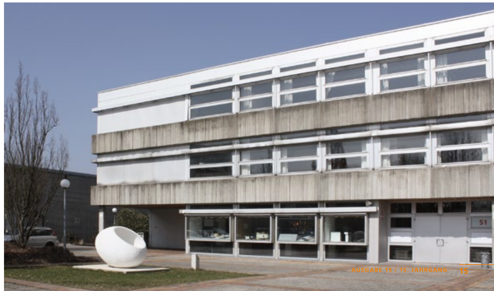
Das Gebäude S1 vor der Sanierung
